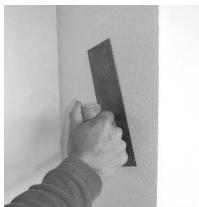
4. 下こすりしたカルクウォールが乾かないうちに、追っかけでカルクウォールを上塗りします。塗り厚は、骨材0.5mmタイプで2mm程度、骨材1.5mmタイプで4mm程度に塗ってください。また、コテで何度もこすると艶が出て、艶ムラになります。仕上げは一度でさっと塗り仕上げてください。
