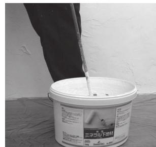
2. ローラーで下地の軽量モルタルの灰色が完全に白く隠れるまで塗布してください。
