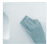
・深く染み込んだ汚れは、一度汚れ部分を取り除いてください。取り除いた周辺を水(霧吹き、スポンジなど)で十分に濡らします。カルクウォールを補修部分が少し盛り上がるよう塗り付けます。余分なカルクウォールを取り除き、スポンジで補修部分と周辺部分の表面を馴染ませるように整えてください。フラット仕上げの場合は、サンドペーパーで表面の凹凸を軽く削り仕上げてください。
